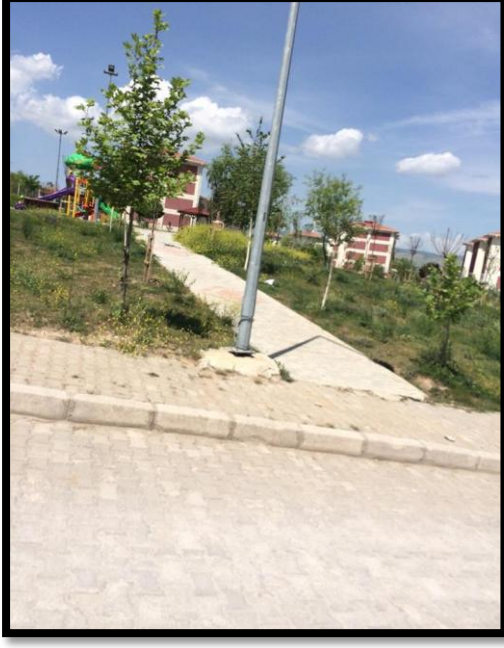
Fotoğraf 45 Oyun Alanına Geçiř İin Kaldırımında Engelli Rampasının Bulunmaması
