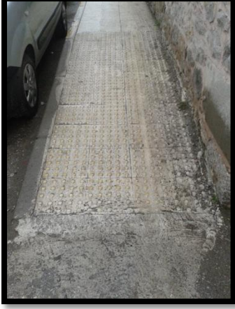
Fotoğraf 21 Kılavuz Çizgilerin Takip Etmediği Kaldırım Bitiş Kabartma Zemini
