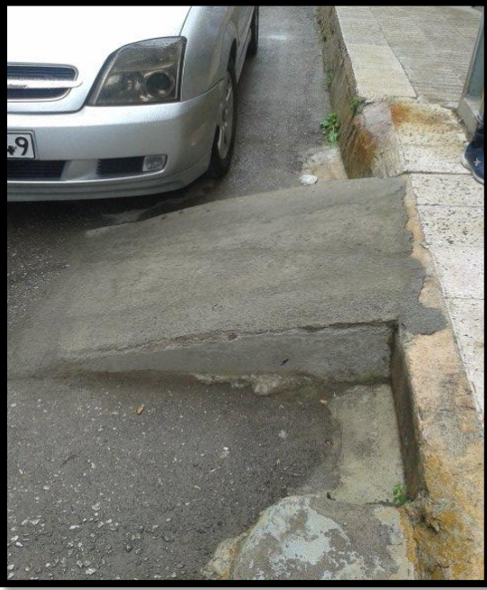
Fotoğraf 74 Uygun Olmayan Eğim ve Genişlikte Rampa
