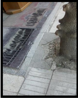
Fotoğraf 19 Tekerlekli İskemle ve Baston İçin Tehlikeli Olan Mazgallar; Kaldırımın Ortasında Elektrik Direkleri ya da Ağaçlar
