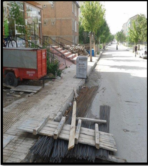
Fotoğraf 83 Kaldırımda Tehlike Oluşturacak Şekilde Bırakılmış İnşaat Malzemeleri
