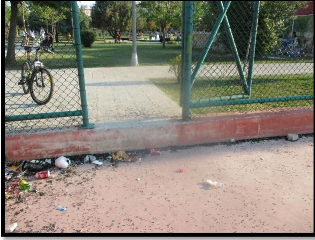
Fotoğraf 15 Mahalle Parkında Basketbol Sahasında Tekerlekli İskeleliler Düşünülmeden Yapılan Giriş/Çıkış (Tekerlekli İskelede En Yaygın Yapılan Sporun Basketbol Olduğu Düşünülürse...)
