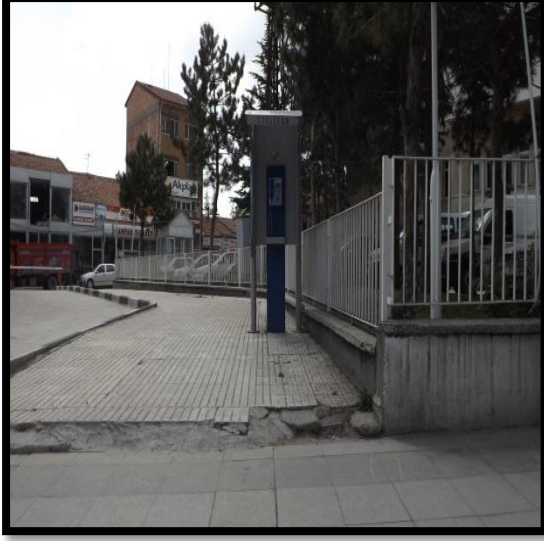
Fotoğraf 55 İki Kaldırım Düzeyinde Seviye Farkları ile Telefon Kulübesinin Engelli Bireyler İçin Azlığına Örnek
