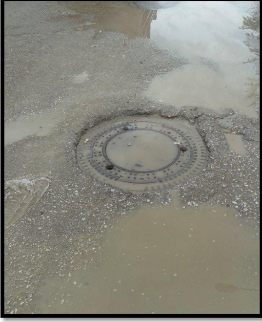
Fotoğraf 80 Yol ile Aynı Hizada Olmayan Mazgal
