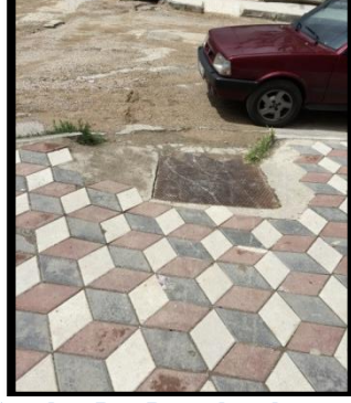
Fotoğraf7 Kaldırımın Yola İnişlerinde Standart Dışı Düzenlemeler
