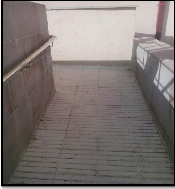
Fotoğraf 49 Korkuluklu ve Dönüş Boşluğu Uygun Rampa
