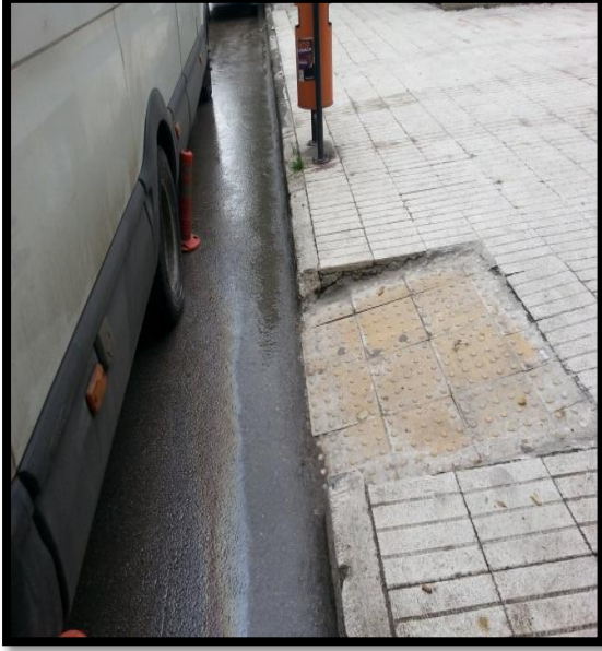
Fotoğraf 63 Arka Devamında Kılavuz Çizgileri Olmayan Ancak Görerek Fark Edilecek Yetersiz Ölçüde Rampa ve Rampa Önüne Park Etmış Araç Örneği
