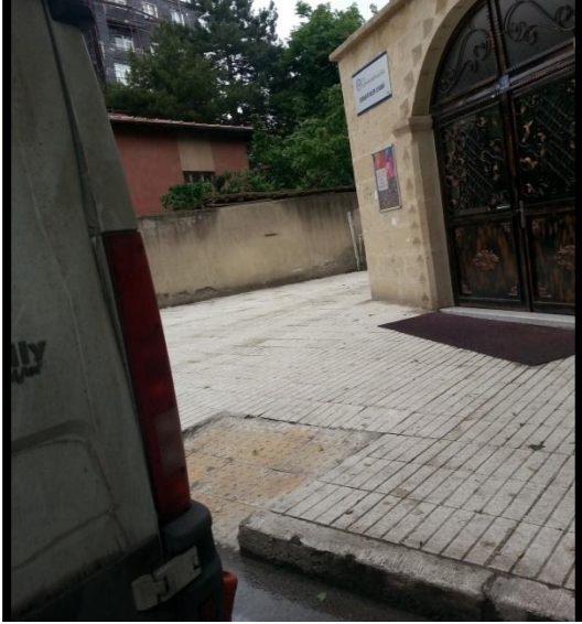
Fotoğraf 66 Arka Devamında Kılavuz Çizgileri Olmayan Ancak Görerek Fark Edilecek Yetersiz Ölçüde Rampa
