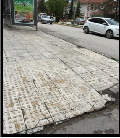
Fotoğraf8 Kaldırımın Yola İnişlerinde Standart Dışı Düzenlemeler
