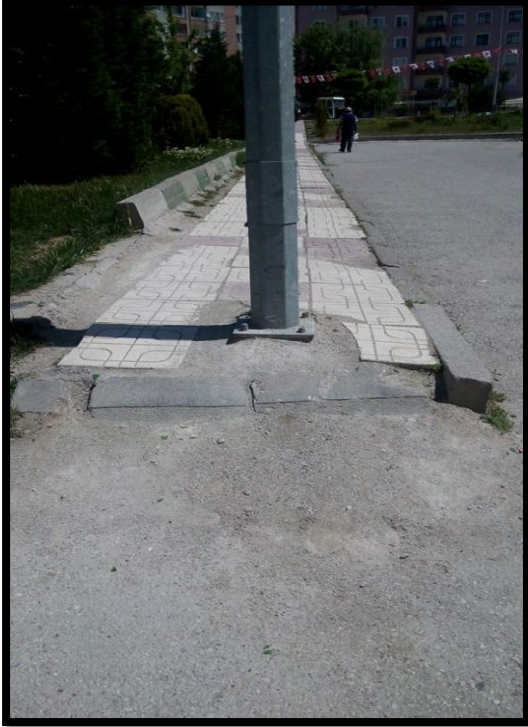
Fotoğraf 36 Zemin, Genişlik ya da Eğimleri Standartlara Uygun Olmayan Yol Bağlantıları
