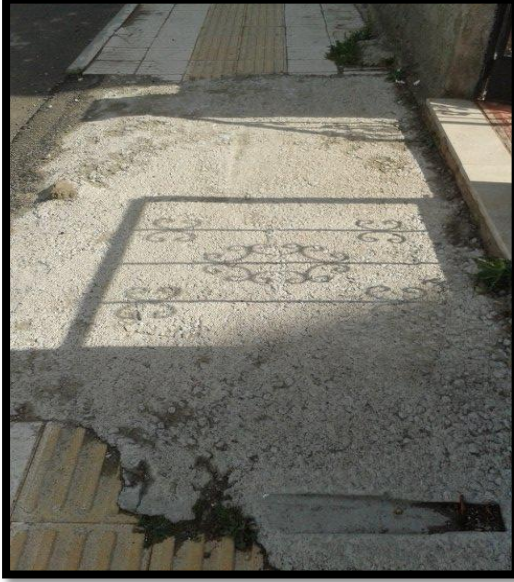
Fotoğraf 86 Kılavuz Çizgisinin Sonradan Betonla Kapatılması
