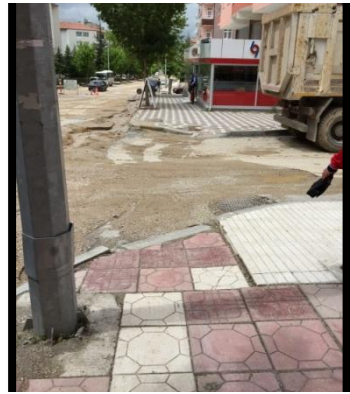
Fotoğraf 6 Kaldırımın Yola İnişlerinde Standart Dışı Düzenlemeler
