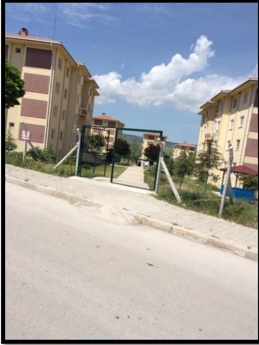
Fotoğraf 44 Siteye Giriş İin Yapılan Rampanın Uygun Standartlarda Olmaması
