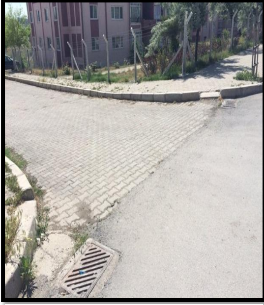
Fotoğraf 38 Zemin, Genişlik ya da Eğimleri Standartlara Uygun Olmayan Yol bağlantıları
