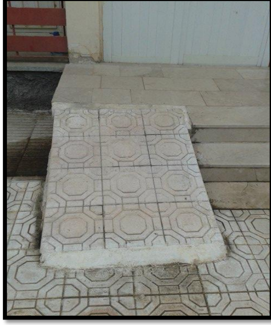
Fotoğraf 82 Uygun Olmayan Rampa, Tekerlekli Sandalyenin Manevra Yapabileceđi Standartlara Sahip Deđil
