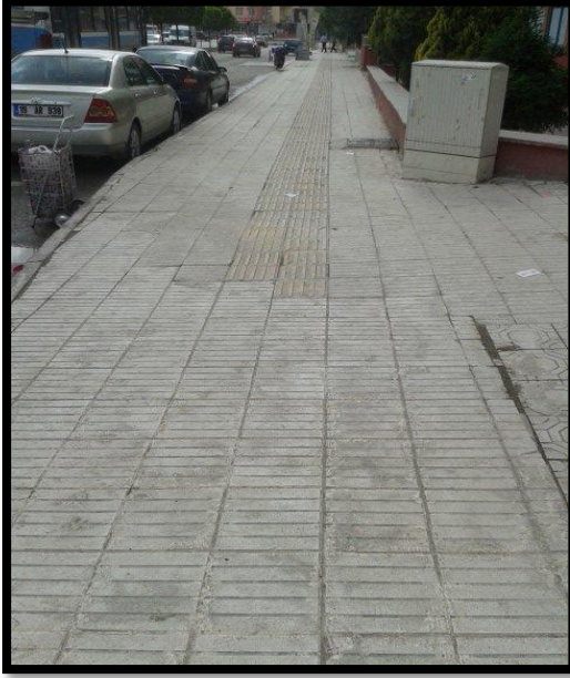
Fotoğraf 88 Kılavuz Çizgilerin Yeni Kaldırım Düzenlemesinde Tekrar Edilmemesi ve Kesintiye Uğraması
