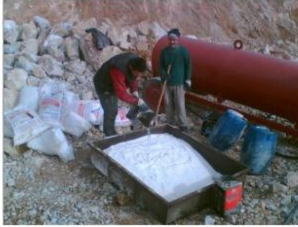
Şekil 2.19. Gübre ve mazot karışımının hazırlanması ve karışımın deliklere doldurulması
