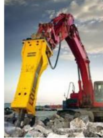
Şekil 2.2. Galeri patlatması sonrası hidrolik kırıcı ile iri blokların kırılması
