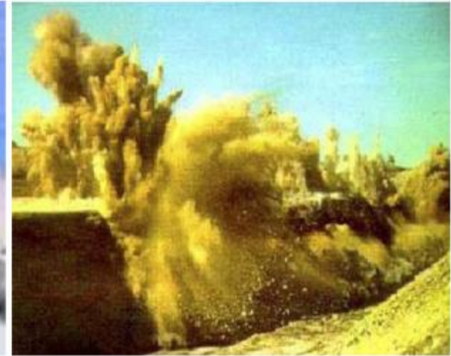
Şekil 2.29. Elektrikli adi kapsül sonucu kötü patlatma uygulaması ve gecikmeli elektrikli kapsüller çok sıralı patlatma sonucu taş fırlamaları
