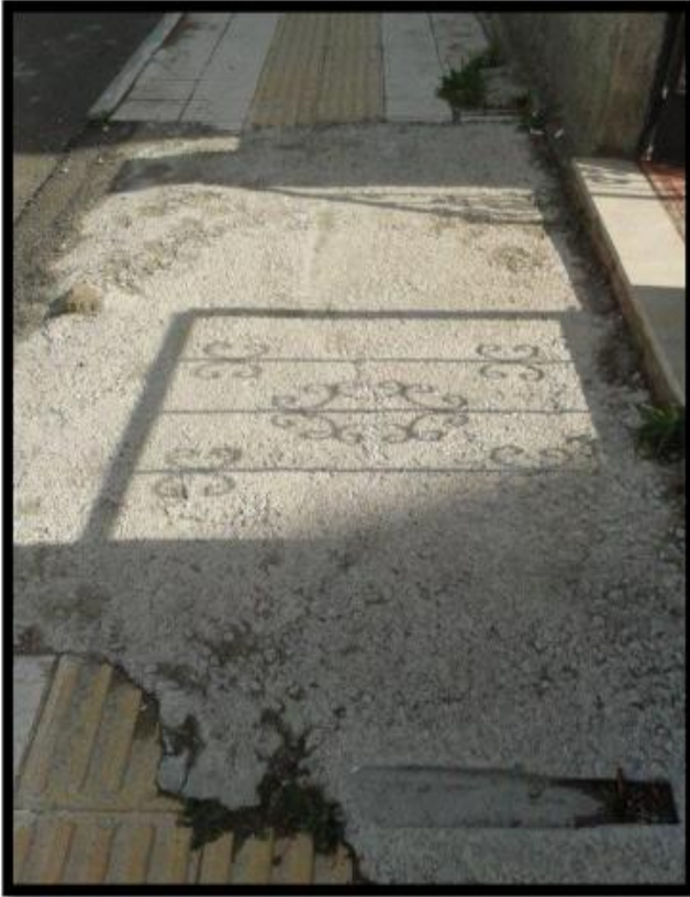
Fotoğraf 86 Kılavuz Çizgisinin Sonradan Betonla Kapatılması
